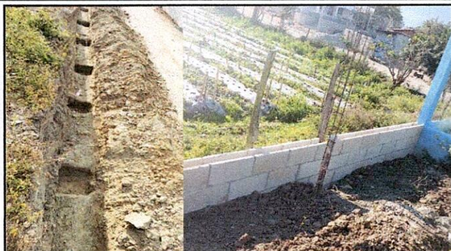
Foto 1: Mejoramiento de cercamiento perimetral: Zanqueo y fundición con armadura de hierro de 64 metros lineales y Levantamiento de Muro con 4 hiladas de block en 53 metros cuadrados
