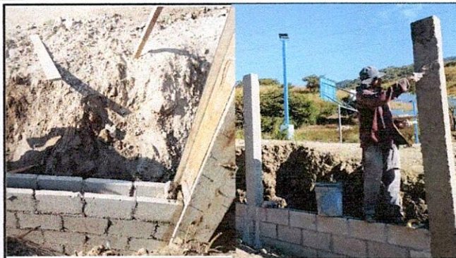
Foto 2: Mejoramiento de cercamiento perimetral: Fundición de 2 columnas 25 x 25 de 4 metros y fundición de 26 columnas de 15 x 20 de 4 metros
