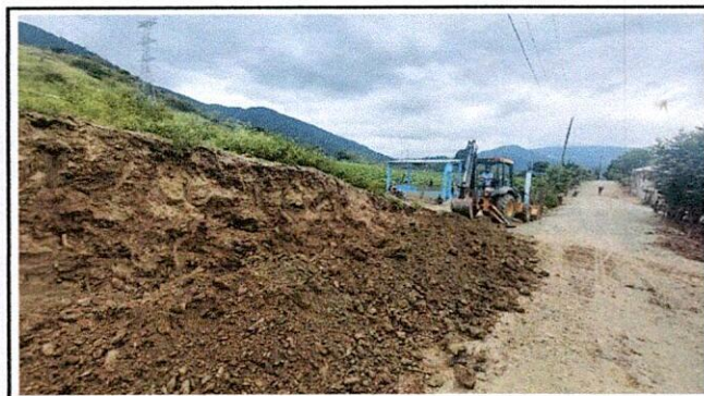
Foto 4: Mejoramiento del acceso peatonal y área perimetral: Extracción de tierra y nivelación de tierra
